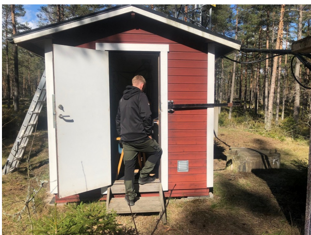
Figur 1: Teknikhus innan förstörelsen
